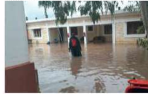
QUESTA HOUSE CLAMMALLAGATA DOPO IL PASSAGGIO DEL CICLONE KENNETH (ARCHIVO CLAMM)
