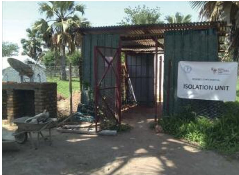
Isolation unit, ospedale di Rumbek, Sud Sudan.
