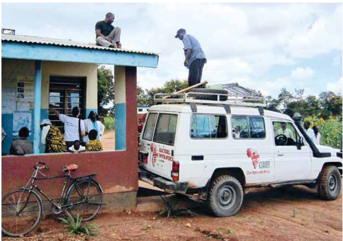
100 Installazione di pannelli solari nei dispensari di Iringa (Archivio Cuamm)
